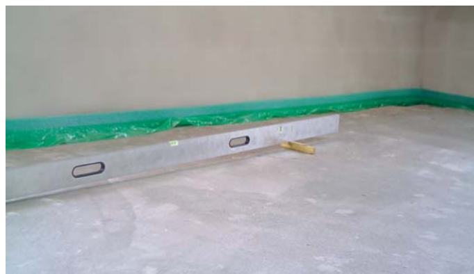
AFBEELDING 8: BOUWPLAATS – DOORHANGENDE VLOER, GENIVELLEERD MET UZIN NC 194 TURBO
