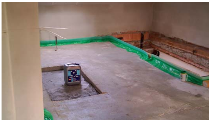
AFBEELDING 3: ONDERGROND MET UITSPARING
