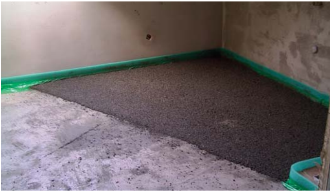
AFBEELDING 9: BOUWPLAATS UITSPARING IN DE VLOER
