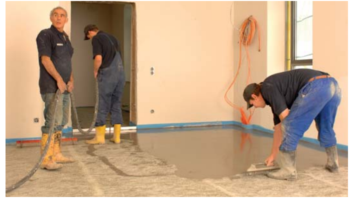
AFBEELDING 12: VERPOMPEN VAN UZIN NC 195
