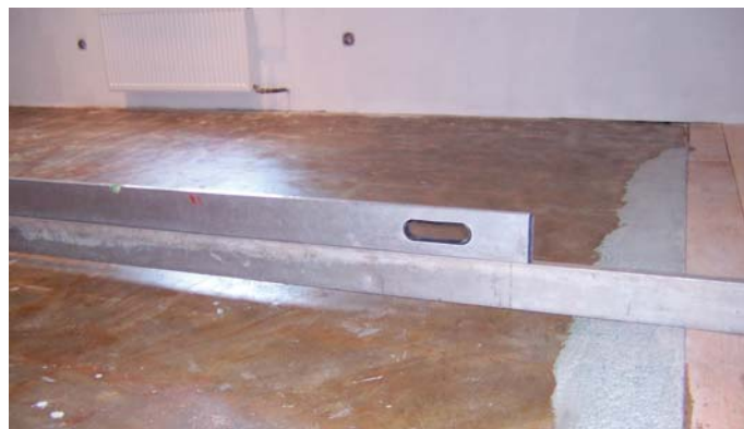
AFBEELDING 7: BOUWPLAATS – DOORHANGENDE VLOER ONDER RICHTLAT
