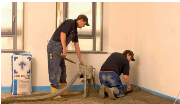
AFBEELDING 4: INBOUW UZIN NC 194 TURBO MET CHAPEPOMP
